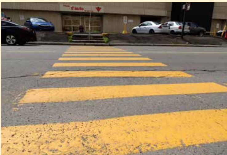
Traverse piétonne sans abaissement de trottoir sur la rue Chabot
