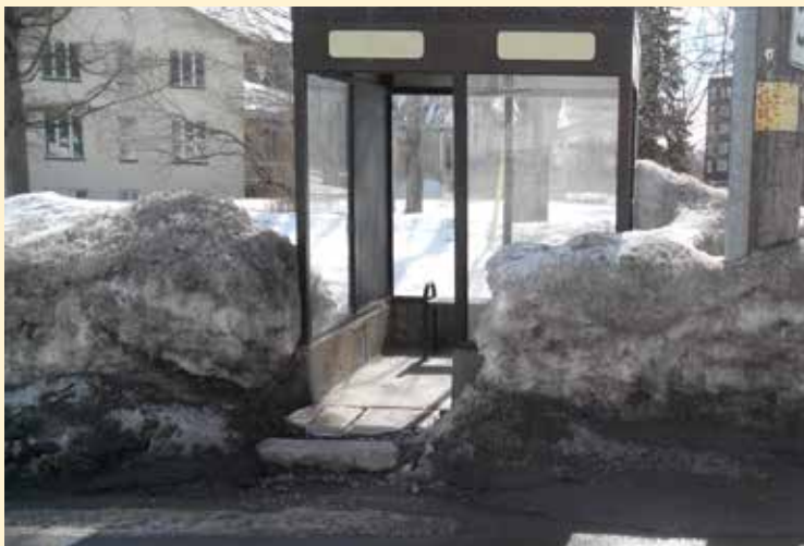
Abribus sans trottoir sur le boulevard Pierre-Bertrand
