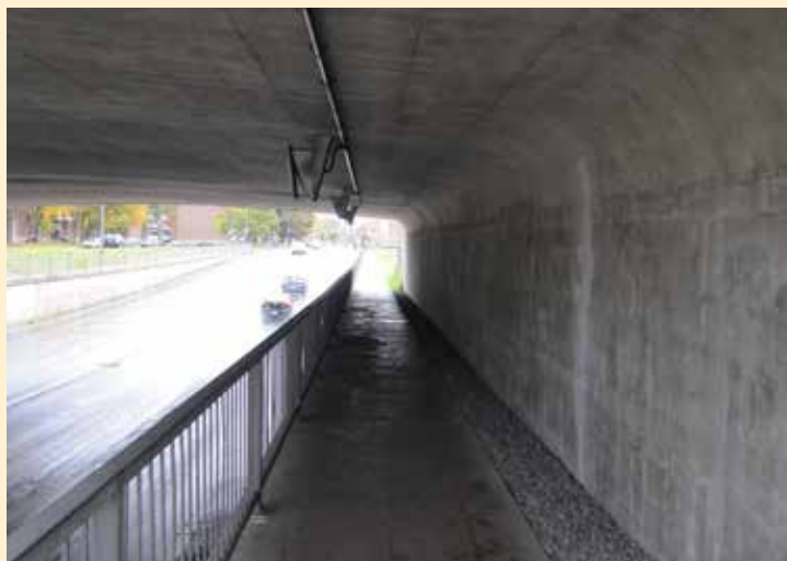
Viaduc de la 4 e Avenue Est
