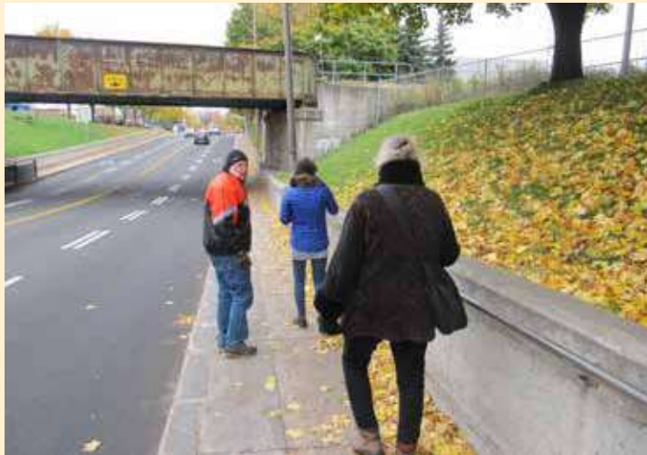
Viaduc de la 1 re Avenue
