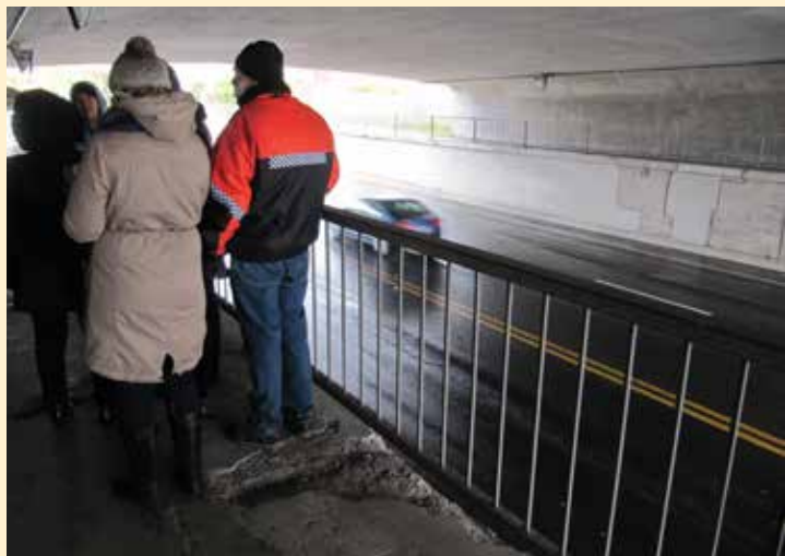
Viaduc de la 4 e Avenue Est
