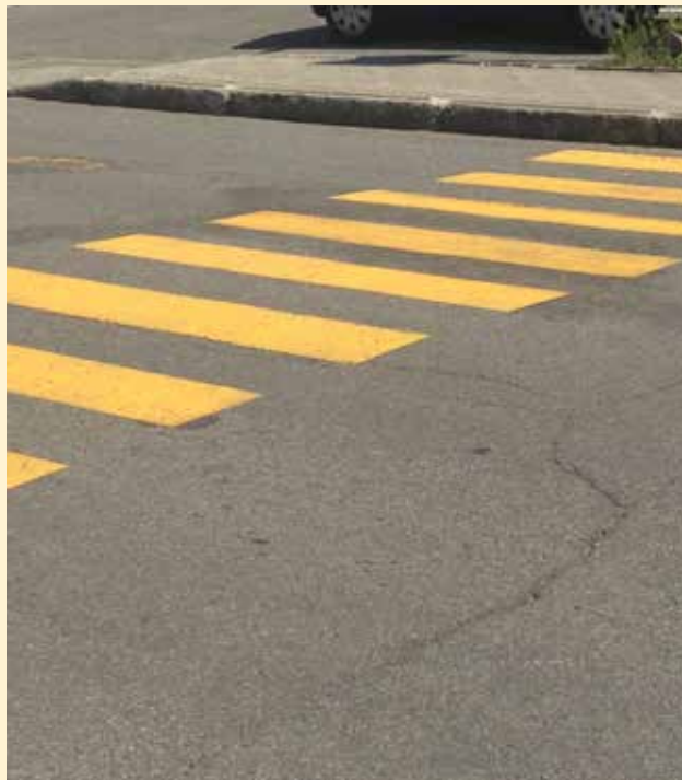
Passage piéton sans abaissement de trottoir
