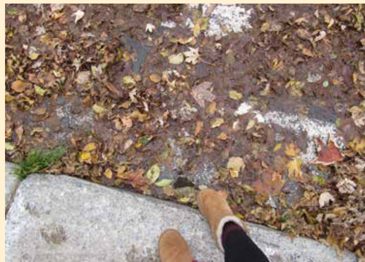
Absence d'abaissement de trottoir au passage piéton à l'intersection de la 2 e Avenue et la rue Godbout
